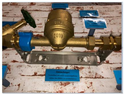
In den meisten Fällen verfügt der Altzähler bereits über den passenden Zählerbügel. In sehr alten Installationen kann es aber vorkommen, dass noch kein Bügel verbaut ist. Dann ist es notwendig, dass Sie noch vor dem Zählerwechsel Ihren Fachbetrieb (Installateur) mit der Nachrüstung beauftragen. Bitte prüfen Sie Ihre Anlage daher vorsorglich, ob ein Zählerbügel vorhanden ist.
