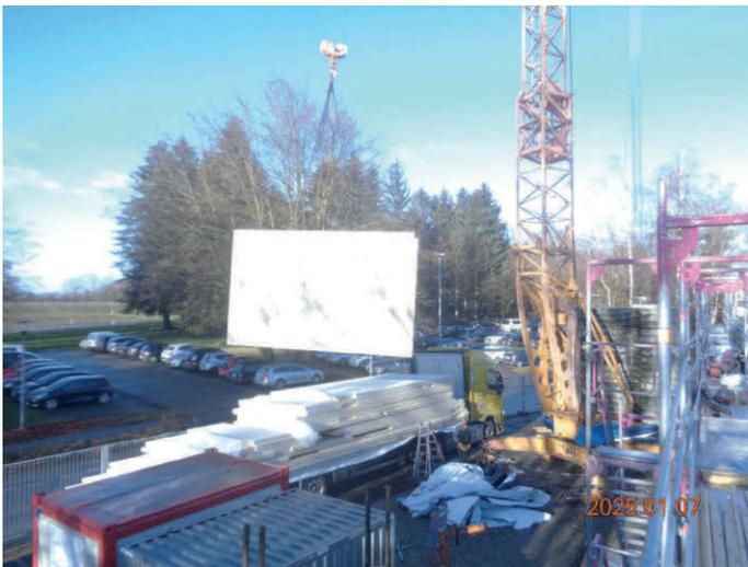
Auf der Baustelle am Hegenberg werden Wände gesetzt. Eine Wand, wie sie auf dem Foto am Kran hängt, wiegt 1442 Kilogramm.
