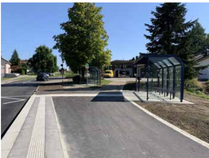
Besondere Bordsteine sorgen dafür, dass die Haltestellenkante nahtlos an die Bustür anschließt.
